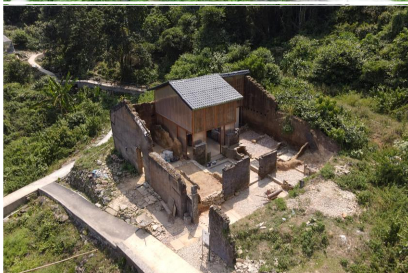
Ruin to Venue 廢墟 > 場地
